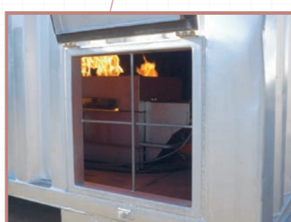
空気取り入れ口 コンテナ内に空気を取り入れるために使用します。また、コンテナ内の排煙訓練時にも利用します。
