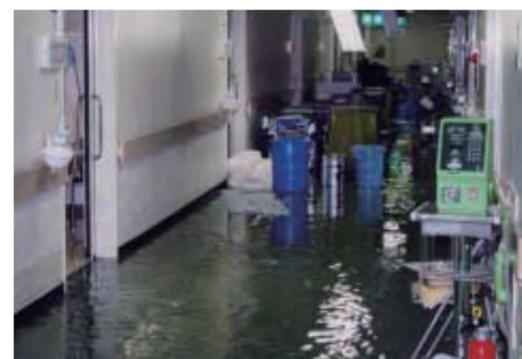
地震により8階の天井裏にあるスプリンクラーの配管が破損し水が漏れ出した。8階の病棟では一時くぶしまで水浸しとなった。入院患者120名は別館病棟へ移動した。復旧までに9日を必要とした。
