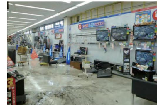
3階のスプリンクラー配管が破断し、3階の在庫商品と2階にある展示商品が濡れてしまい処分された。
