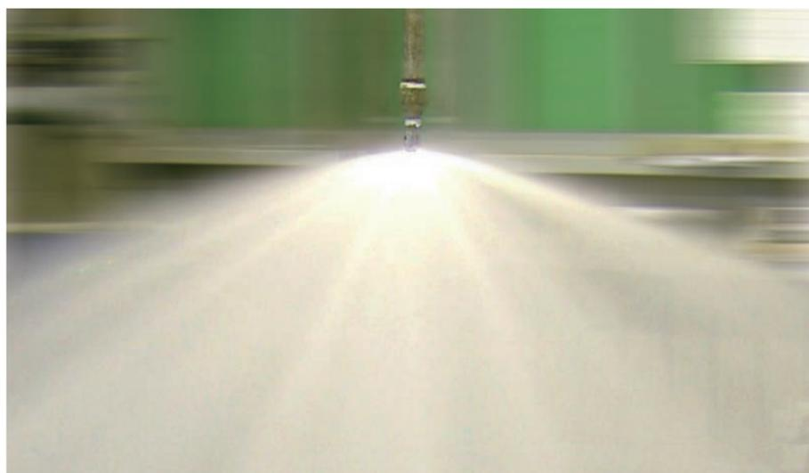
しかし、この湿式スプリンクラーは火災時以外でも大量の加圧水を放出する不慮の事故を引き起こし、重大な漏水被害を多発させていることが問題になっています。
