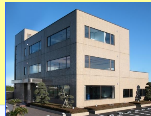
樹脂管プレハブ工場 及び 事務所棟、展示室
