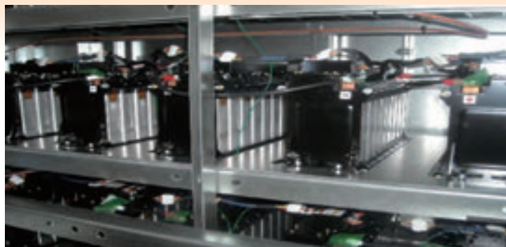
リチウムイオン電池に設置した6×4mmのセンサーチューブ
