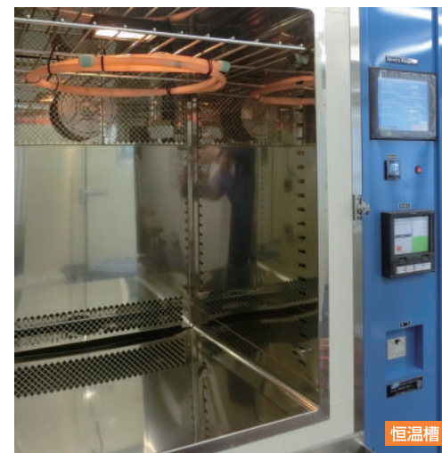
制御盤・配電盤
