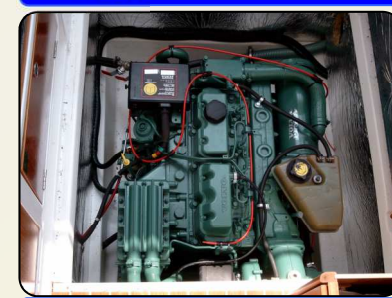
ボート エンジンルーム
