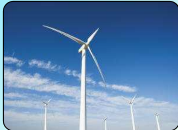
風力発電設備
