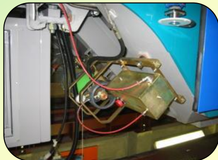
モノレール車両ブレーキ部
