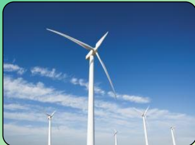
風力発電設備
