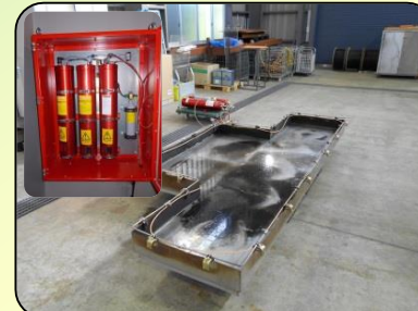
風力発電設備 (タワー内)
