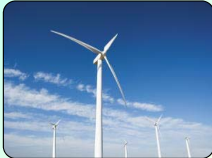
風力発電設備
