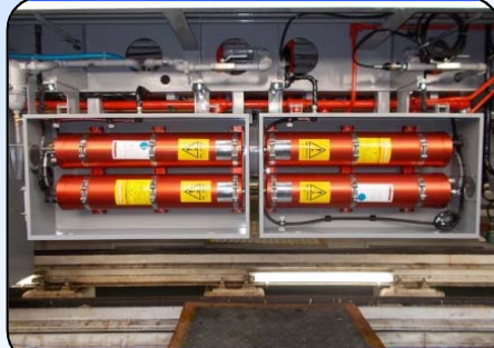
鉄道車両エンジンルーム
