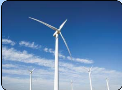
風力発電設備
