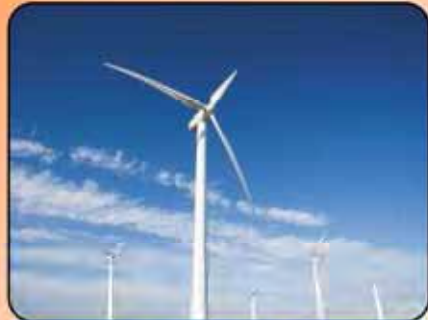
風力発電設備
