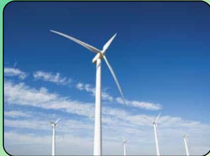
風力発電設備
