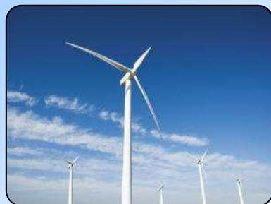
風力発電設備
