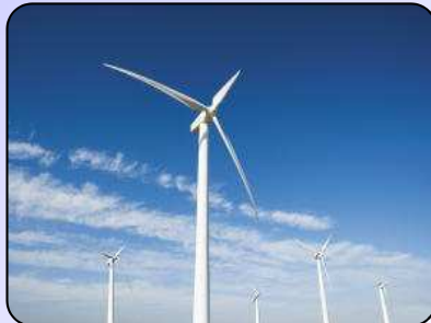
風力発電設備
