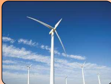
風力発電設備
